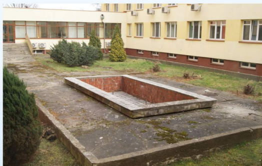
Patio, w którym powstanie nowy budynek
